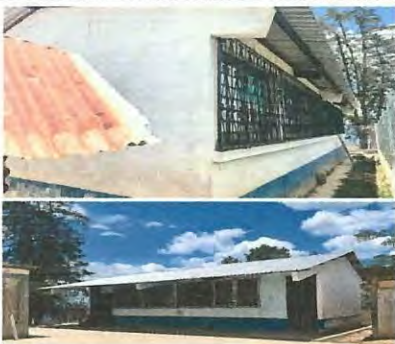
Foto 5: Se realizará pintura de exteriores de aulas
