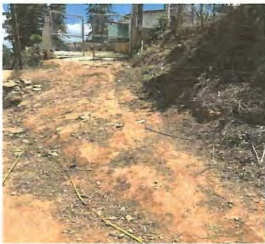
Foto 3: Se realizará recubrimiento con plancha de concreto de área de entrada
