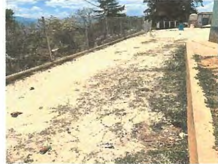
Foto 2: Se realizará recubrimiento con plancha de concreto de área de patio
