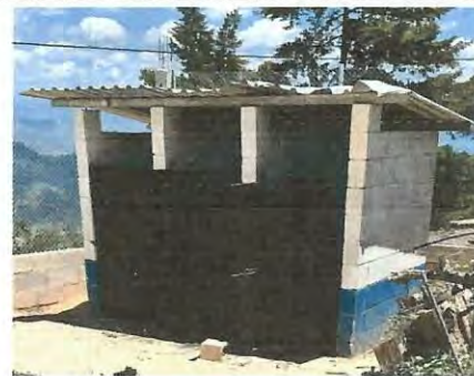
Foto 6: se realizará pintura de interiores y exteriores de baños
