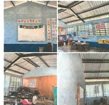
Foto 4: Se realizará pintura de interiores de aulas
