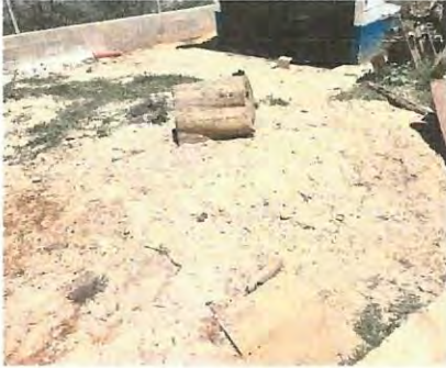
Foto 1: Se realizará recubrimiento con plancha de concreto de área de patio
